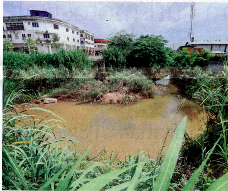
WALAUPUN kejadian banjir kilat hampir sebulan berlalu, runtuhan tebing sungai di Batu 23, Jalan Batu Arang-Rawang, Selangor masih belum diperbaiki sehingga kini.
