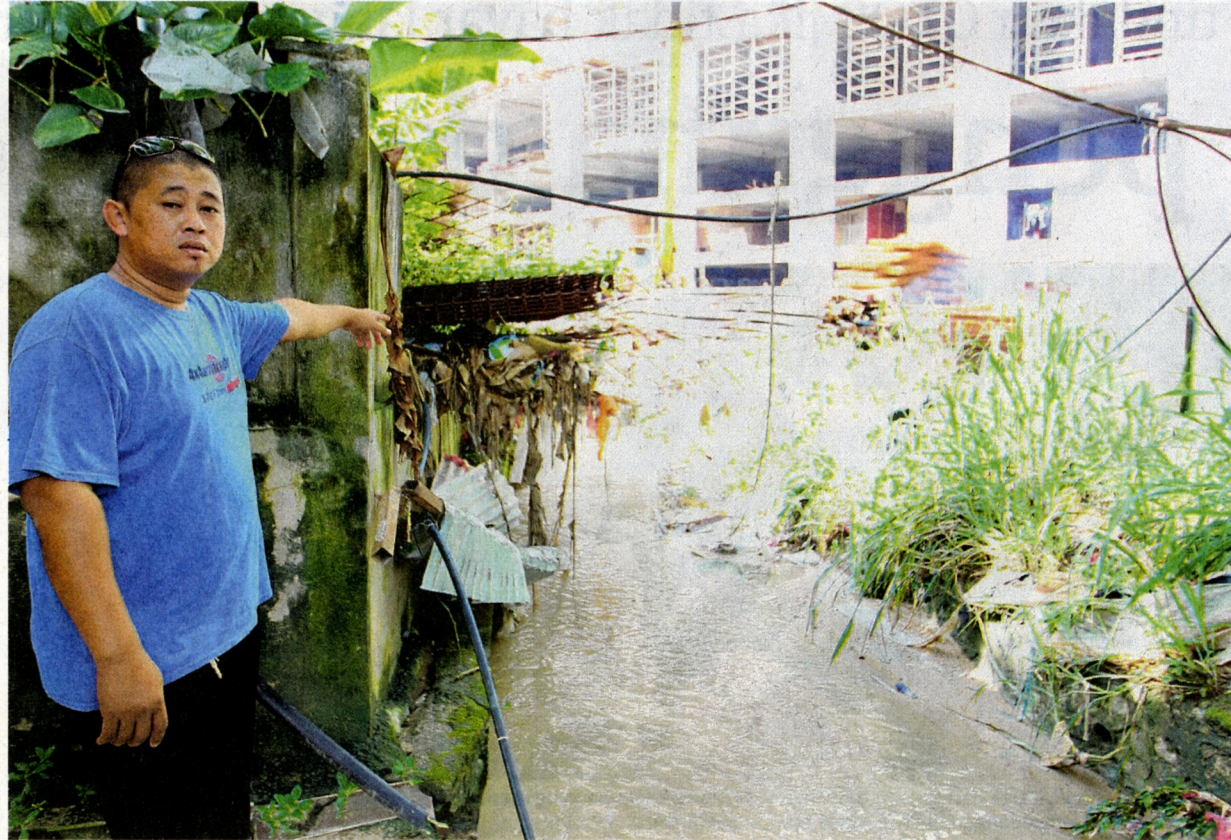
NOR Azli Salih menunjukkan sampah sarap yang tersangkut pada pokok di tebing anak sungai di belakang rumahnya sebagai bukti ketinggian aras air setiap kali banjir kilat melanda di Kampung Bukit Lanjan di Damansara, Petaling Jaya, Selangor, semalam. - UTUSAN/NASIRRUDDIN YAZID
