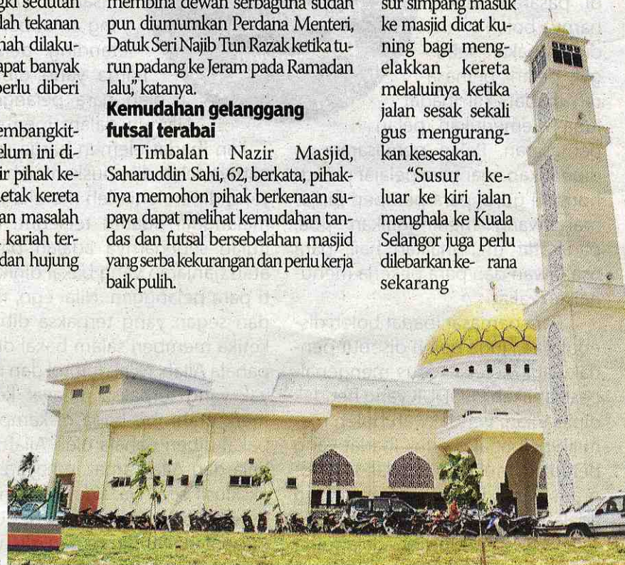
Masjid baru yang memerlukan kerja baik pulih bagi kerosakan kecil.
