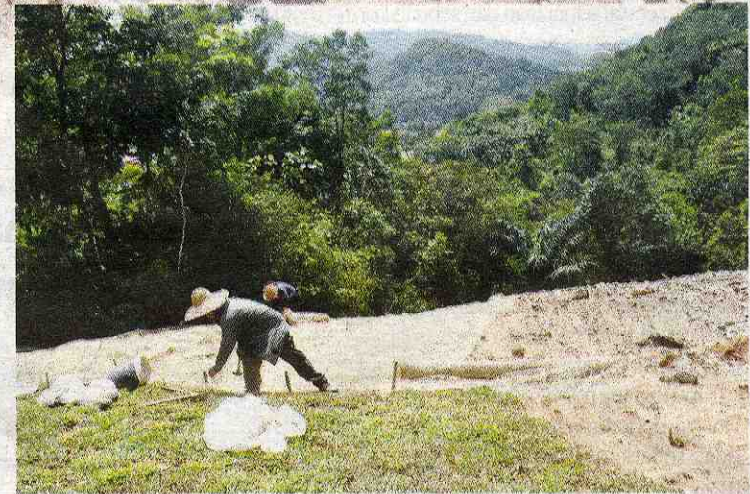
Penahan tebing menggunakan 'geo mat' dipasang.
