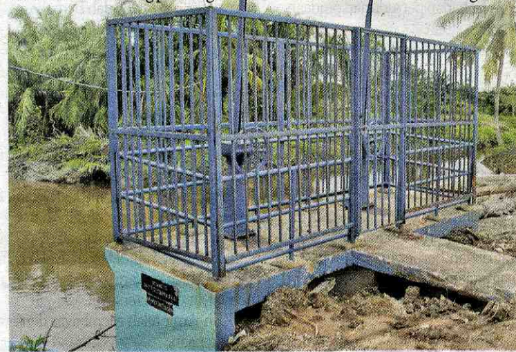
Struktur kunci air lama didakwa lebih sempurna berbanding kunci air baru.
