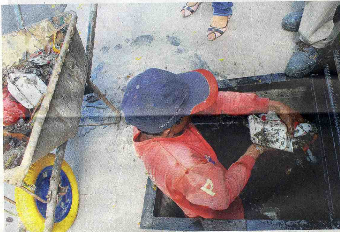
SEORANG pekerja pembersihan mengeluarkan sampah-sarap dari dalam longkang di Jalan Railway 1/2 yang menjadi punca banjir kilat.
