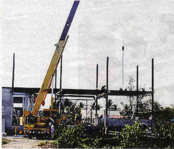
Sebuah jentera digunakan bagi merobohkan jeti pendaratan ikan yang dibina atas tanah kerajaan.
