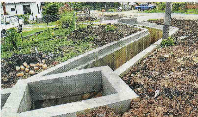
Kerja naik taraf sistem saliran elak air bartakung giat dijalankan.
