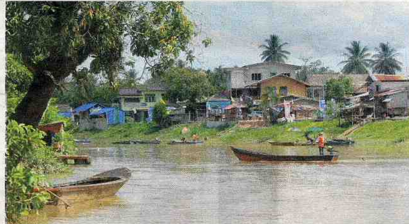
KERJA-KERJA membina benteng di Sungai Golok akan bermula pada September ini.
