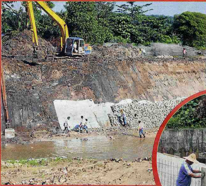
Kerja mendalamkan Sungai Plentong yang dilaksanakan pada Julai 2011 hingga Januari 2013 menerusi Rancangan Tebatan Banjir (RTB) Jabatan Pengairan dan Saliran Johor.
