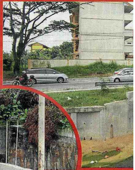
Pekerja pembinaan sedang mendirikan tembok menghalang hakisan tebing berdekatan jambatan Ros Merah Utam Jaya.
