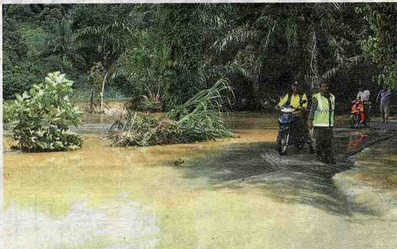
Kawasan tebing sungai yang runtuh selepas kawasan penempatan penduduk di Kampung Rantau Panjang dilanda banjir.
