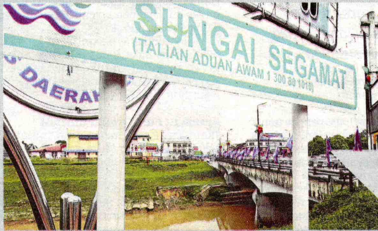
Projek JPS yang menaikkan taraf Sungai Segamat bagi mengatasi banjir.
