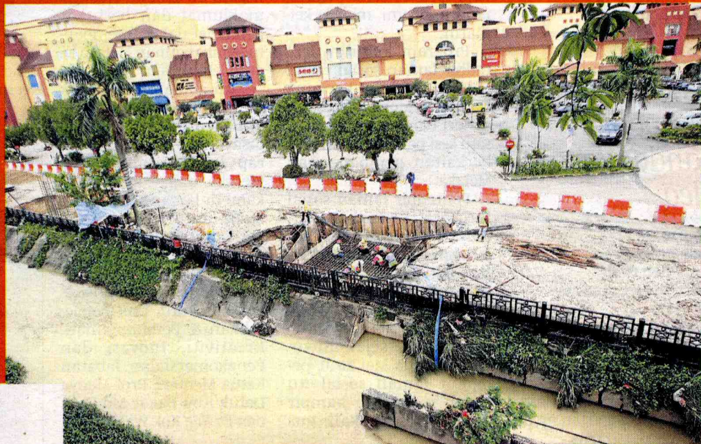
Pekerja projek MRT membuang air yang bertakung dalam konkrit berikutan banjir kilat di sekitar Puchong, kelmarin.
