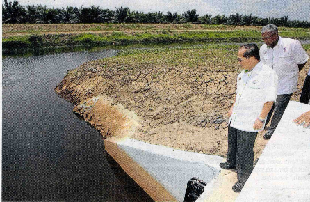
Douglas (depan) meninjau rancangan tebatan banjir di lembangan Sungai Muar berhampiran pintu air di Sungai Pagoh, Pagoh.
