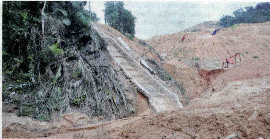
Tadahan konkrit yang dibina bertujuan mengurangkan pergerakan tanah selain sistem saliran air.
