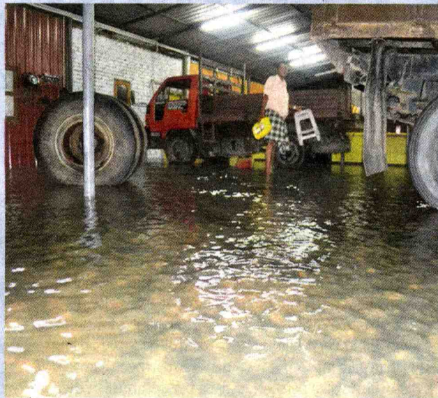
Premis perniagaan di Jalan By Pass digenangi air selepas hujan lebat menyebabkan penyewa mengalami kerugian.
