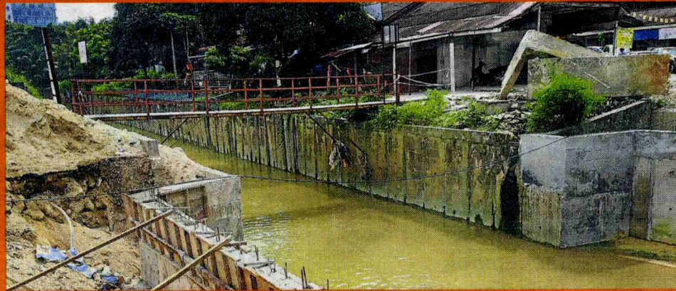
Kerja meninggikan jambatan Sungai Jeluh, Kajang giat dijalankan. (FOTO SARAH SULAIMAN/BH)
