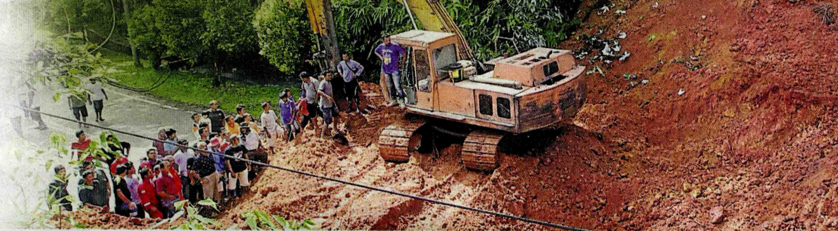
Jentolak membersihkan tanah runtuh di Kilometer 139 Jalan Jerangau-Jabor, manakala gambar kecil, kereta PRODUVA Viva milik Rafliza yang remuk selepas ditimbus tanah. [FOTO IMRAN MAKHZAN/BH]
