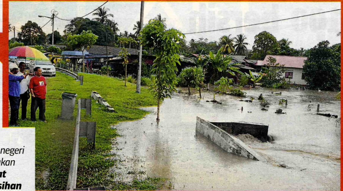
Penduduk menunjukkan pembetung yang sempit dipercayai menjadi punca banjir kilat di Kampung Pegoh, Alor Gajah.
