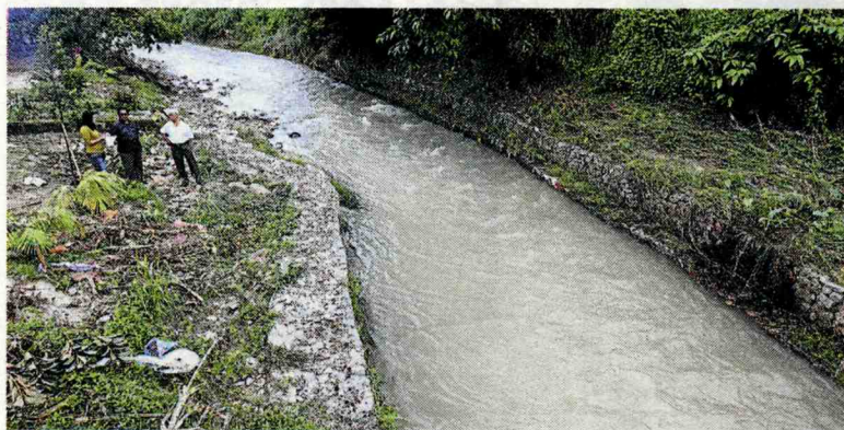
Sungai Gombak yang menjadi punca banjir kilat di Kampung Salak, Batu 10.
