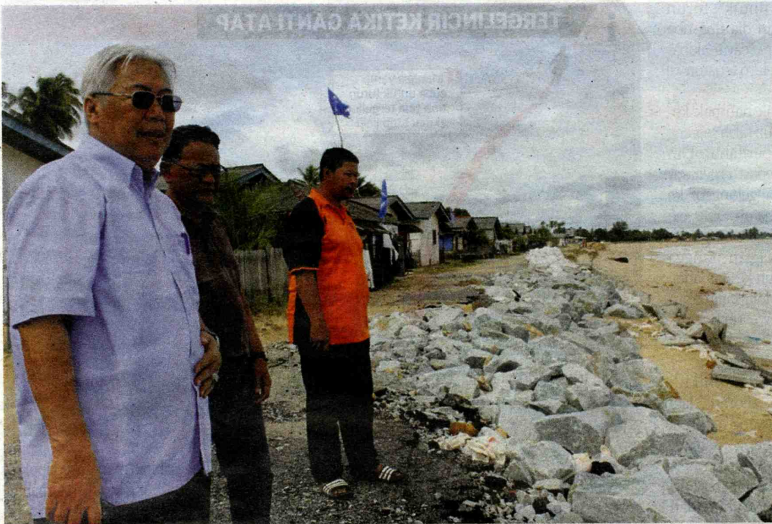
A Rahman meninjau pesisir pantai di kawasan PPRT Pangkalan Atap yang telah ditimbun bongkahan batu untuk mengurangkan hakisan.
