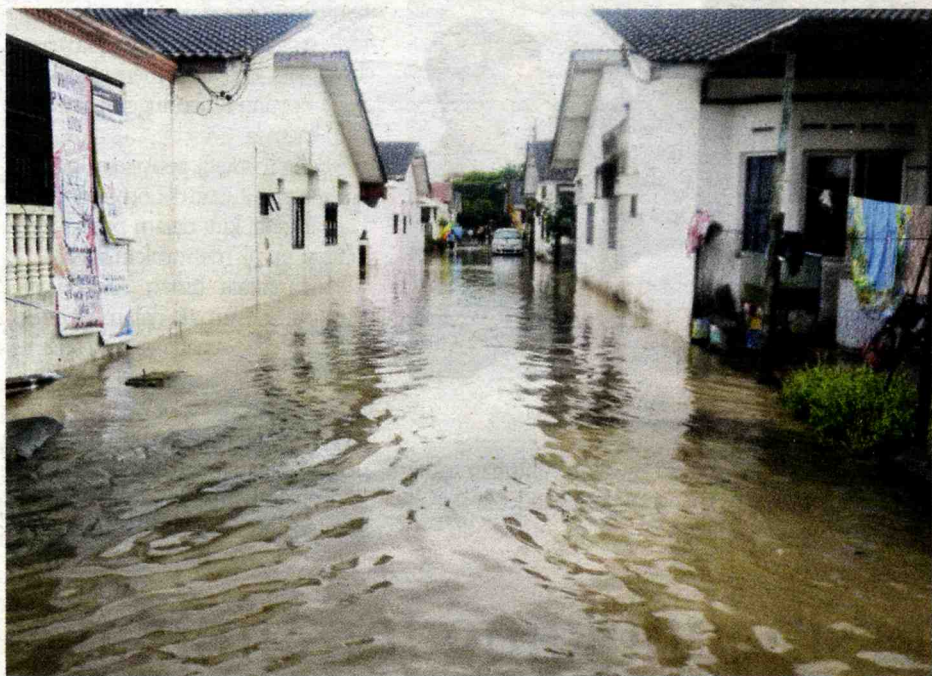
Kawasan sekitar Jalan Norton, Taman Yayasan dinaiki air didakwa berpunca daripada projek naik taraf sistem saliran.
