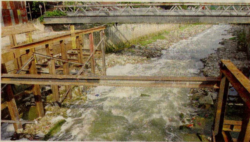
CEGAH: Dinding konkrit dipasang elak tanah runtuh.
