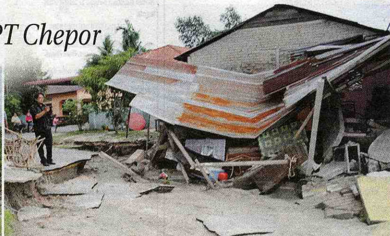
Keadaan gerai makan yang ranap dalam kejadian tanah runtuh, kelmarin.
