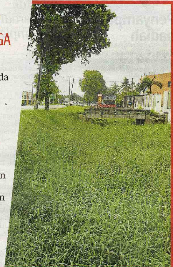
Parit yang tidak diselenggara di Kampung Tanggavelu, Kampung Jawa.
