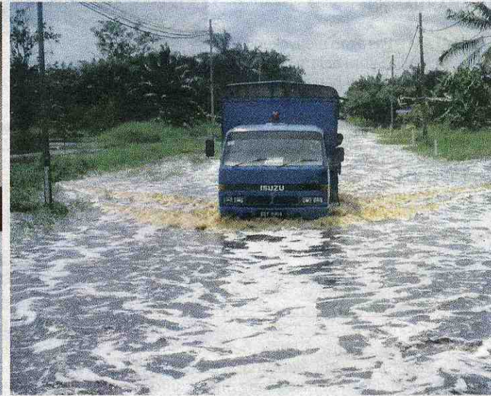
Antara jalan yang dinaiki air dan terpaksa ditutup untuk kenderaan ringan.
