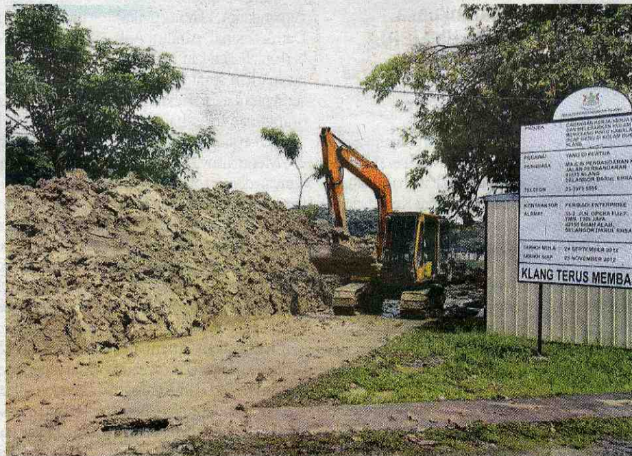
Kerja-kerja naik taraf sedang giat dijalankan di Bandar Bukit Tinggi.
