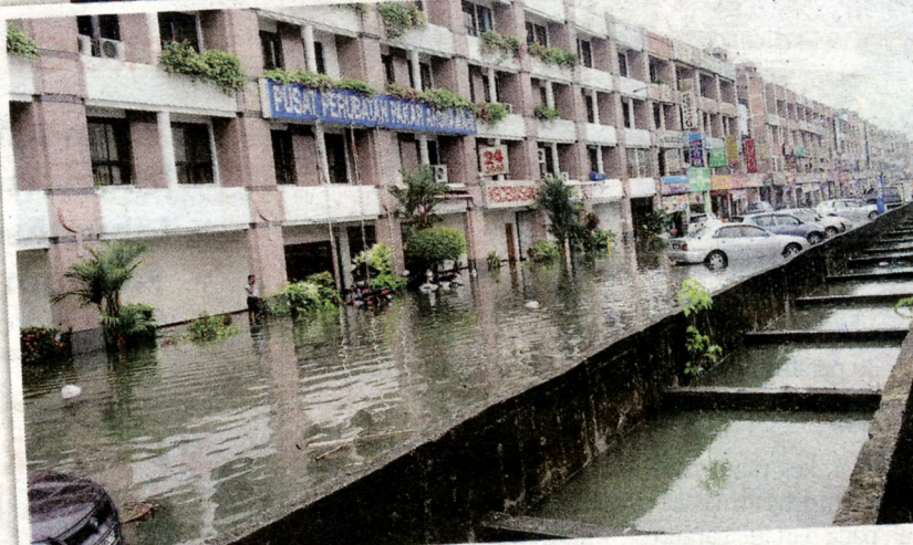
Paras air yang naik cepat menyebabkan pengguna tidak dapat menyelamatkan kenderaan masing-masing.
