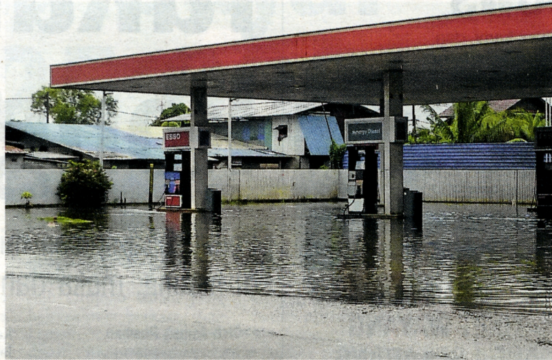
TENGGELOM... stesen minyak yang ditenggelami air banjir kilat di Padang Jawa.
