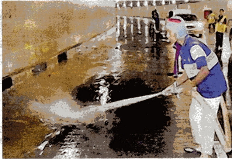
PARA pekerja melakukan kerja-kerja pembersihan pada terowong SMART setiap kali ia digunakan untuk lencongan air.
