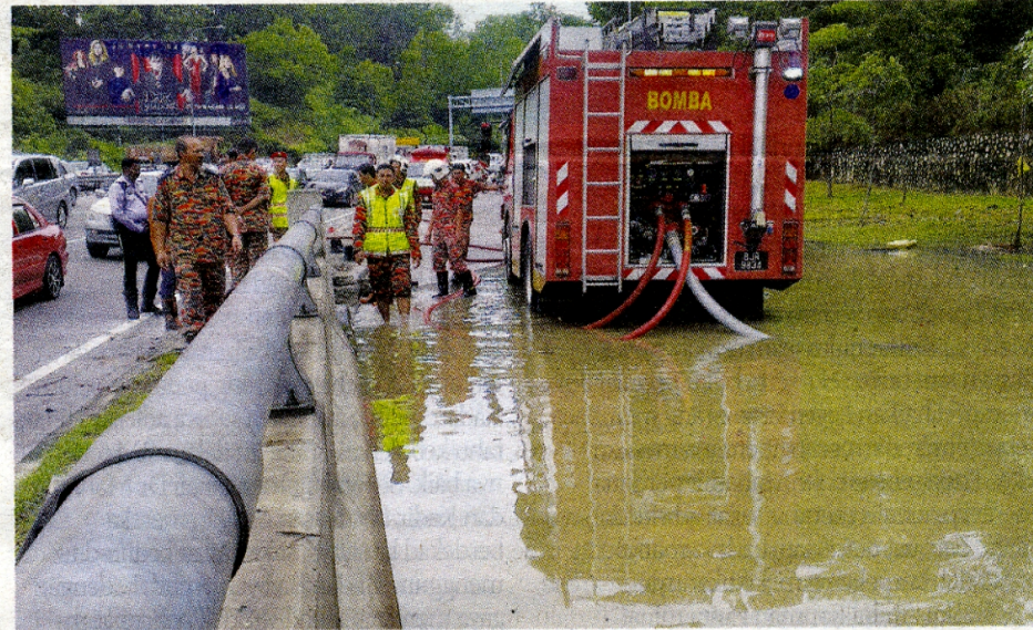
Bomba ketika mengepam keluar air yang bertakung di susur masuk ke Jalan Duta.
