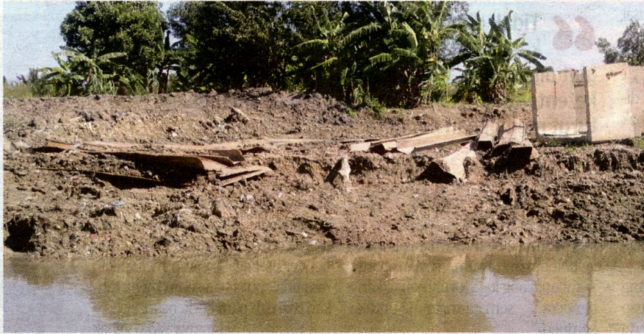
Kelihatan tanah yang dikorek dilonggokkan di tepi tebing sungai selain kalbord belum dipasang ketika projek pembinaan Jambatan Kampung Delek dibina kontraktor.
