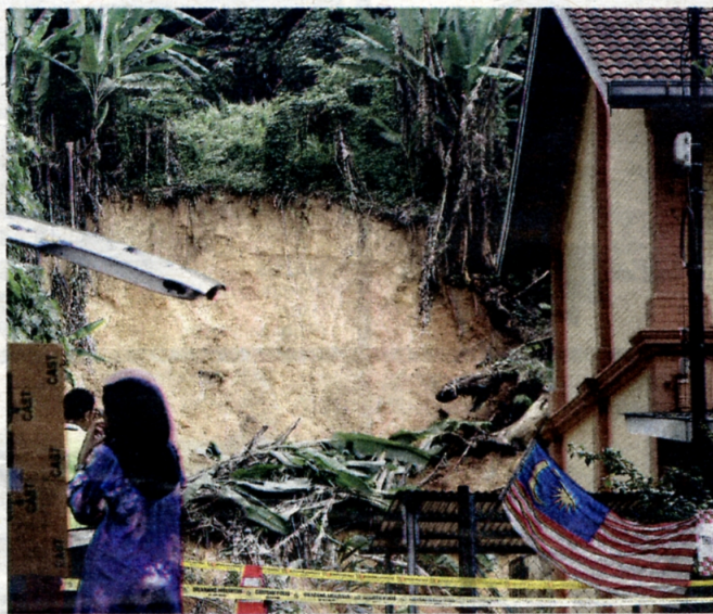
KAWASAN kejadian tanah runtuh yang mengakibatkan Raja Muhammad Irfan maut di Jalan Belfield, Kuala Lumpur semalam.
