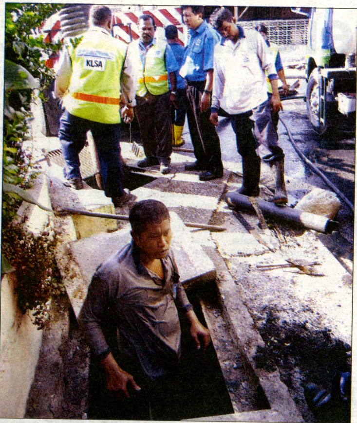
PEKERJA Alam Flora giat membersihkan longkang di Jalan 3, Kampung Cheras Baru kelmarin.
