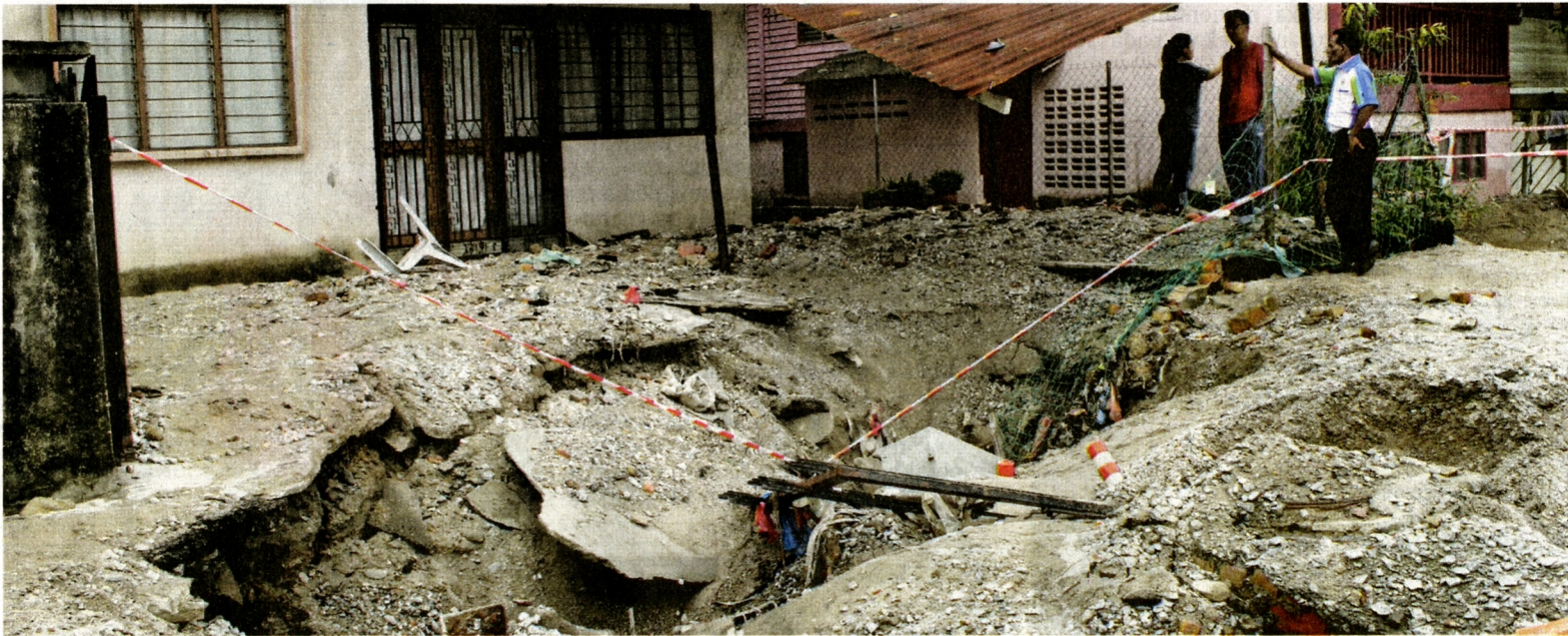
LUBANG yang terbentuk akibat tanah mendap di Jalan Mahdi, Kampung Baru, Kuala Lumpur kelihatan semakin buruk menyebabkan penduduk bimbang ia akan membahayakan rumah mereka. – UTUSAN
