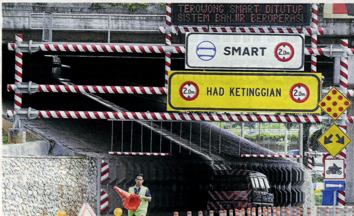
TEROWONG SMART satu-satunya binaan yang berfungsi sebagai jalan dan mengurangkan banjir besar, khususnya di Kuala Lumpur.
