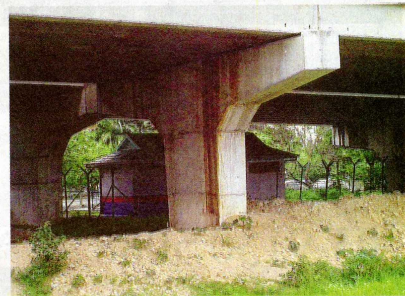
TAMBAK: Tebing Sungai Damansara yang ditinggikan bagi mengelak air sungai melimpah.
