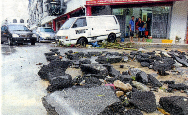
JALAN rosak selepas air surut.
