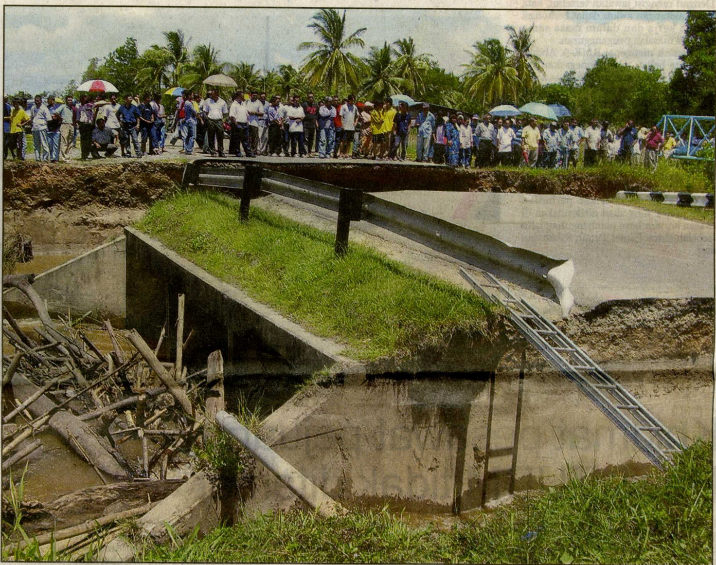
TERPUTUS... Longgokan sampah dan kayu yang menyekat aliran air telah mengakibatkan pangkal jambatan merentangi Sungai Mandahan, Papar runtuh, semalam.
