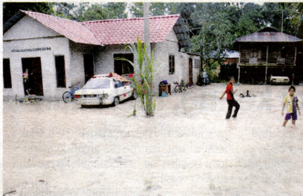
Keadaan rumah penduduk yang dilanda banjir kilat setiap kali hujan lebat.
