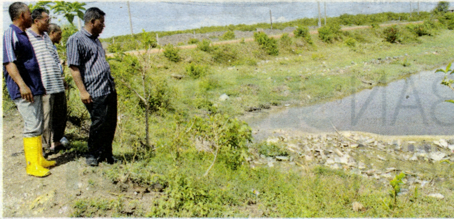
Penduduk melihat keadaan parit yang tersumbat akibat kerosakan pada kalbot yang mendap.
