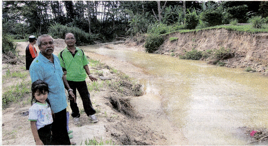
Kamaruzaman (depan) dan Mohd Nor semasa meninjau keadaan hakisan tebing sungai yang menjejaskan tanah kebunnya yang berada di sebelah kanan.
