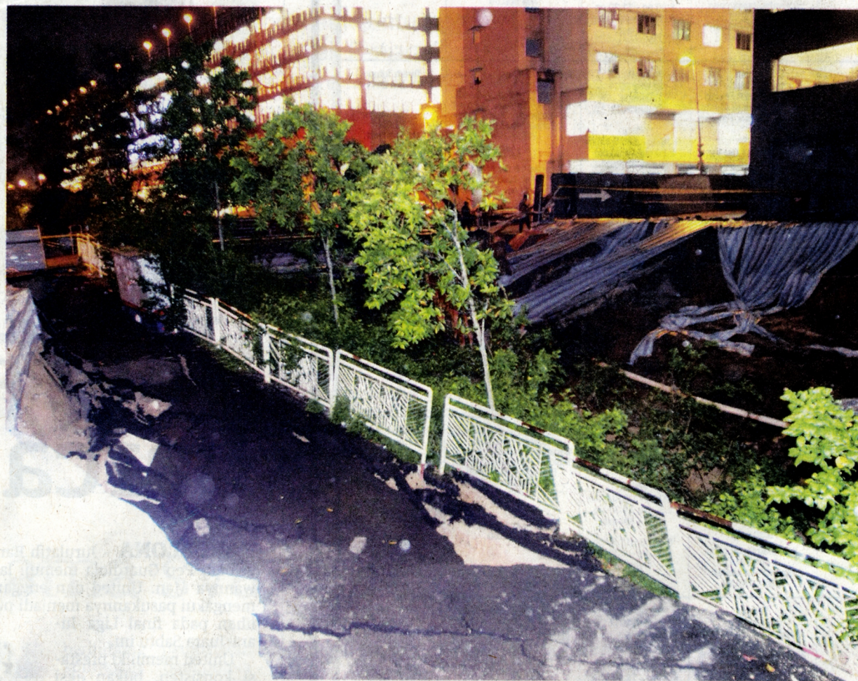
KEJADIAN tanah runtuh yang menyebabkan jalan menghubungkan beberapa blok kediaman rosak di Petaling Jaya, semalam.
