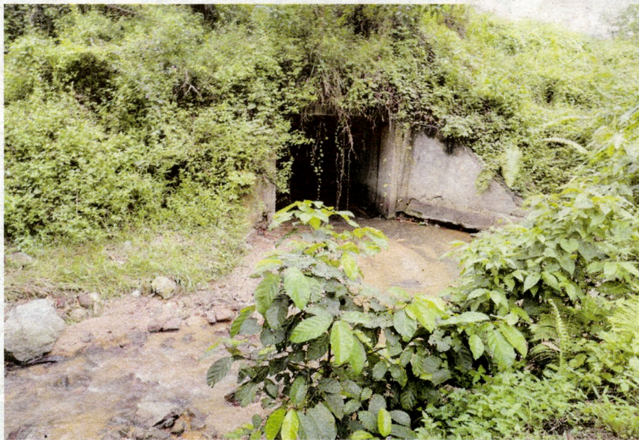
■ Culvert di bawah laluan jalan dilebarkan membawa arus besar semasa hujan.
