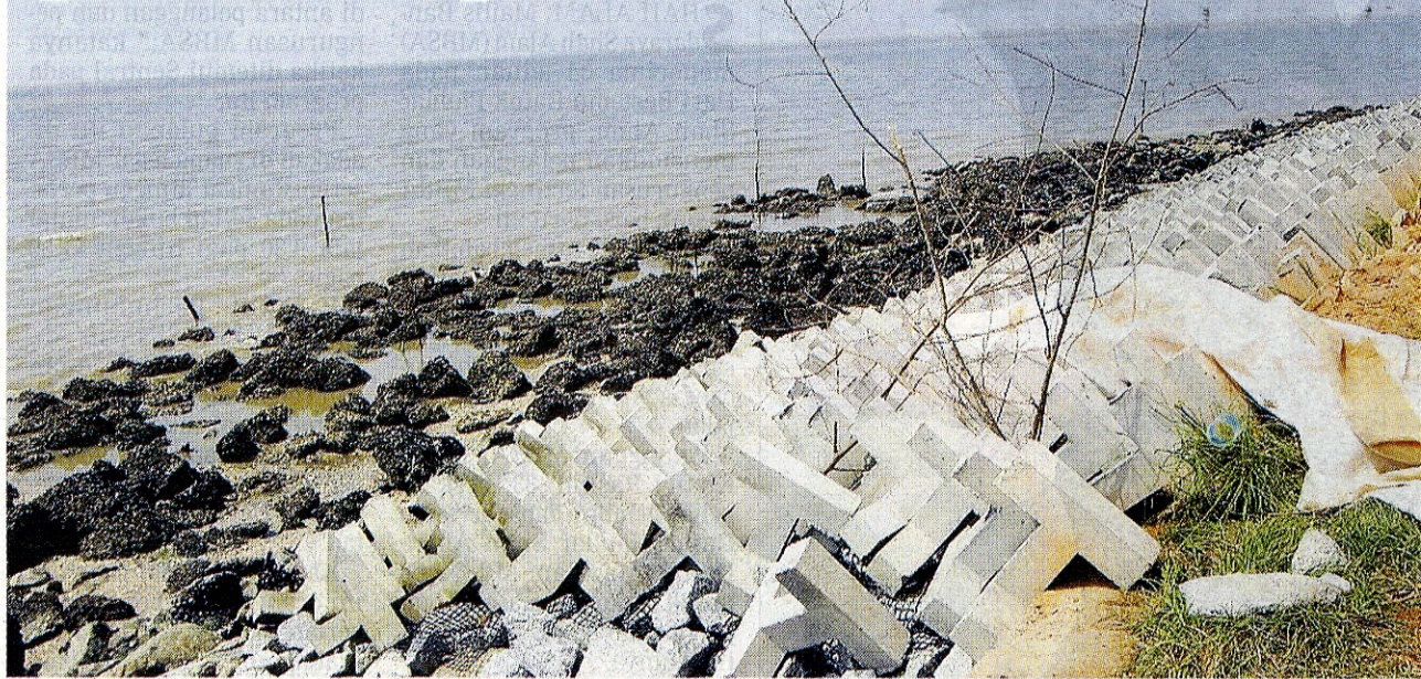
STRUKTUR kawalan hakisan yang dipasang struktur di pinggir pantai Tanjung Sauh.
