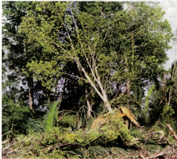
■ Kelihatan kerja mencerooboh sedang giat dijalankan.
