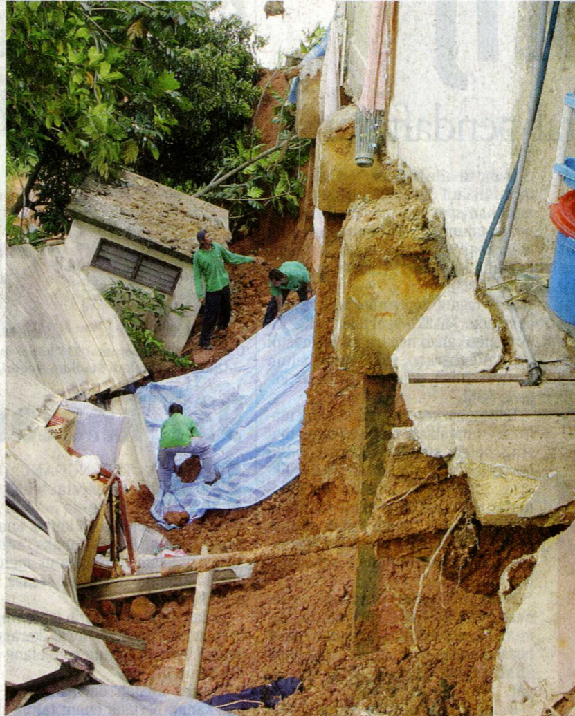
LANGKAH KESELAMATAN: Beberapa pekerja menutup bahagian yang runtuh dengan lapisan plastik.
