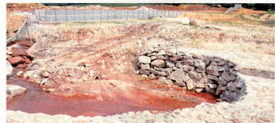
Keadaan kolam takungan yang dibina menggunakan batu bukit.
