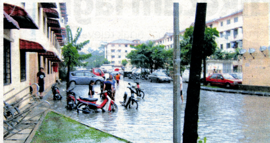
Keadaan banjir di Blok H akibat kelemahan sistem perparitan.
