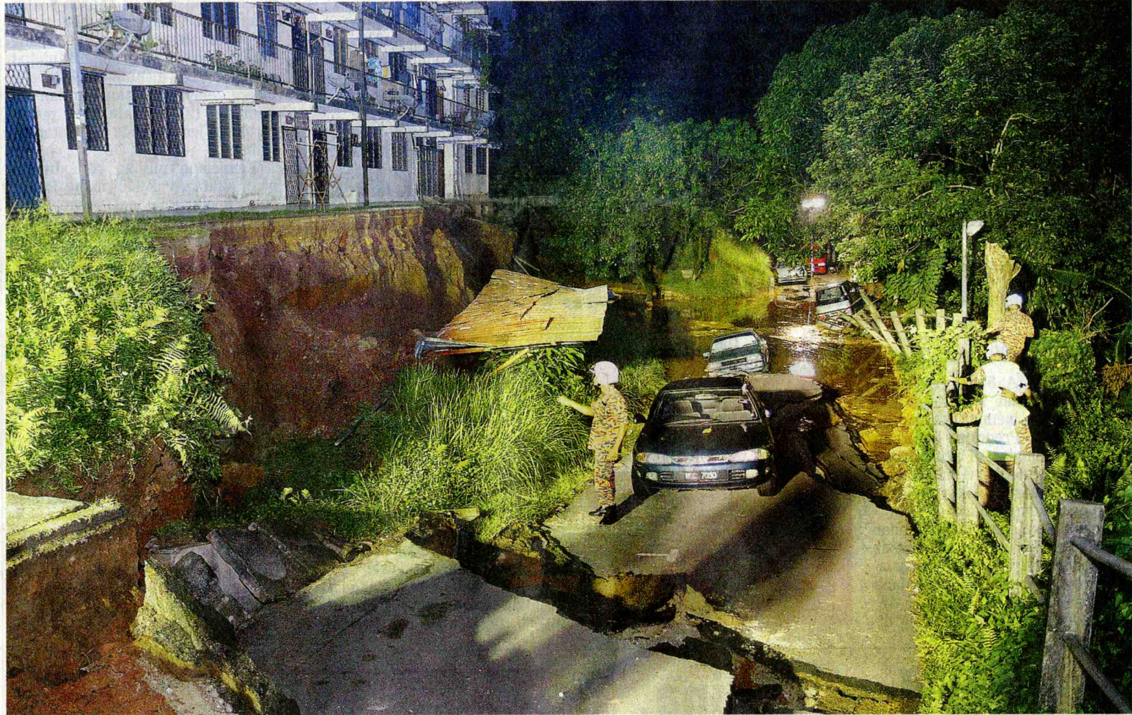
KEADAAN BERBAHAYA: Runtuh tanah dan retakan di jalan belakang flet kos rendah Seksyen 10 Wangsa Maju, malam tadi.
