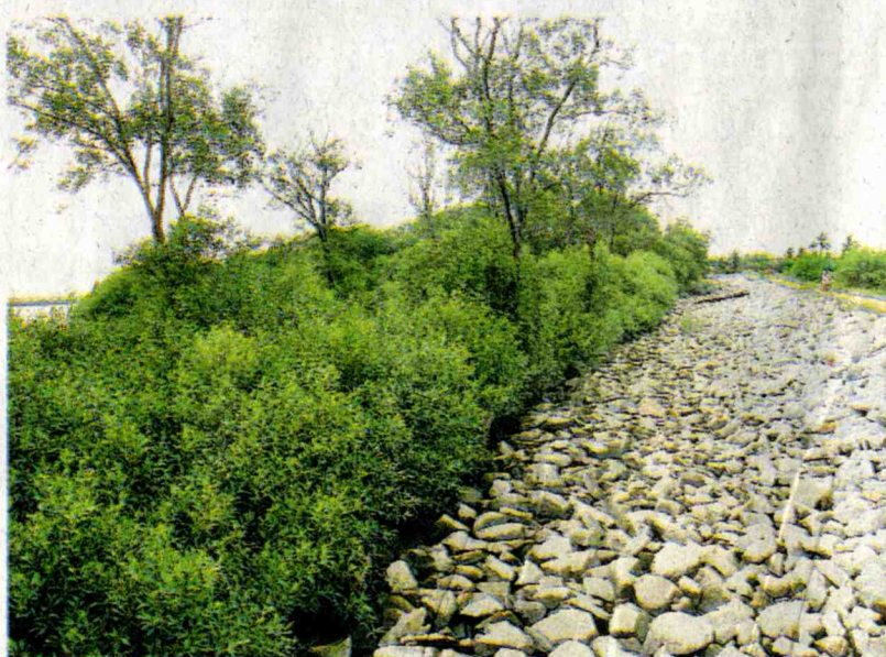
TERSUSUN: Tebing pantai ditambak batu bagi perkukuh kedudukan tanah.
